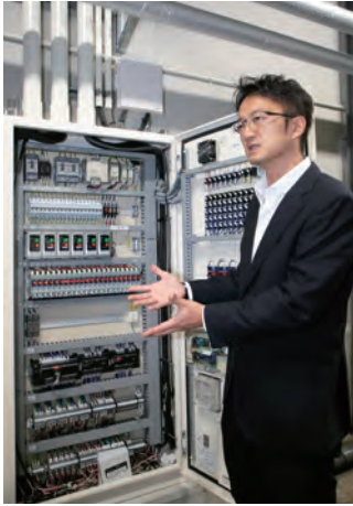
蓄養水槽に異常が発生した場合、警報により水質悪化を回避
