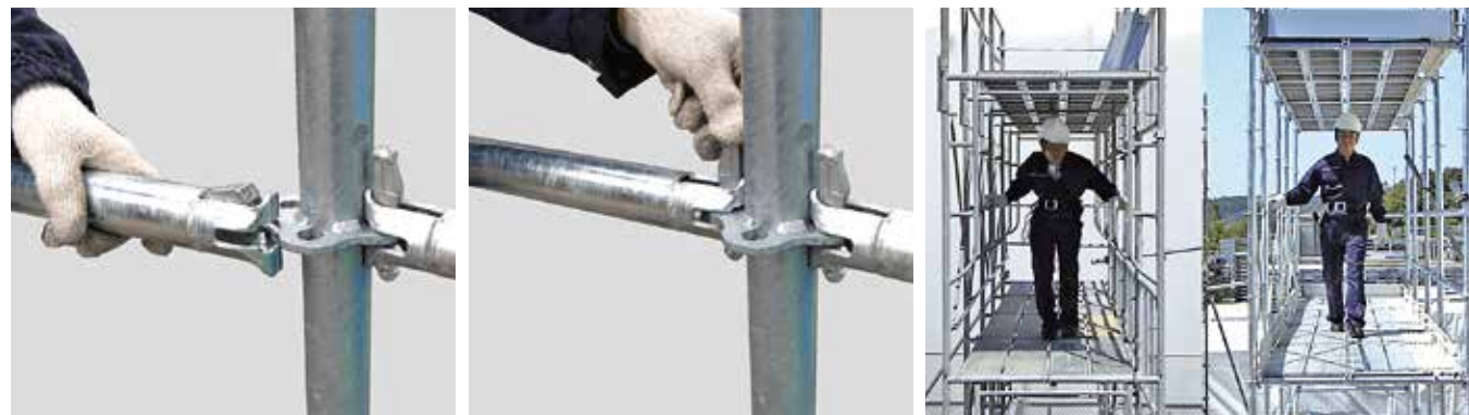
はめ込みにクサビを差し込む組立方式
