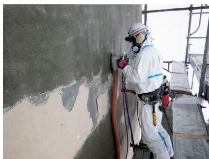
超高压剥離吸引除去
