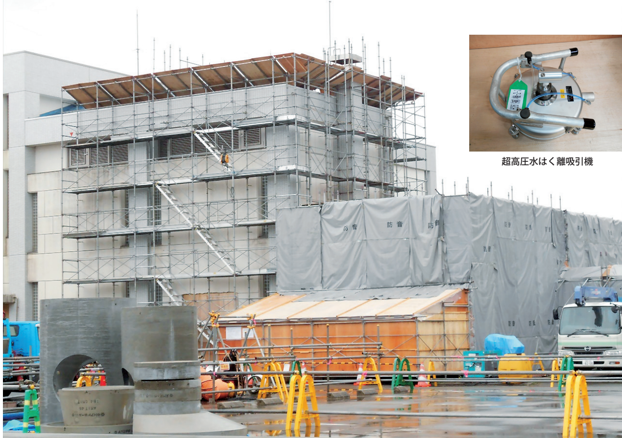
超高压剥離吸引除去工法による作業現場
