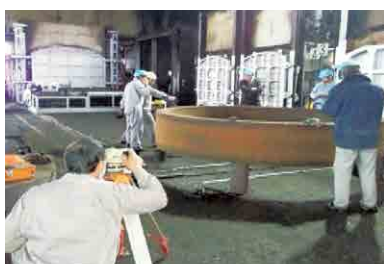
油圧ジャッキで平行出しを行い、水準器で変形度合いを含めた寸法確認を実施
