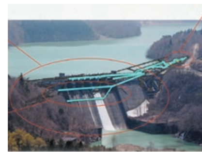
ダム全景。右側にある管理所・予備電源室から堤体へと通路・監査廊が続いている
