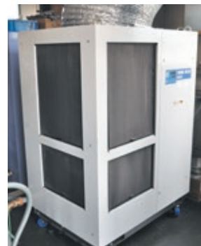
導入されたサーモチラー
