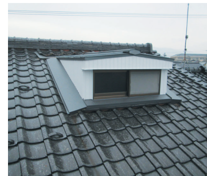
屋根・板金工事施工例
