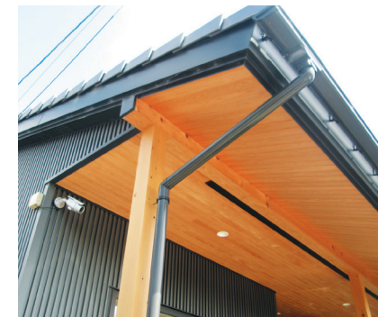
屋根・板金・雨樋工事施工例
