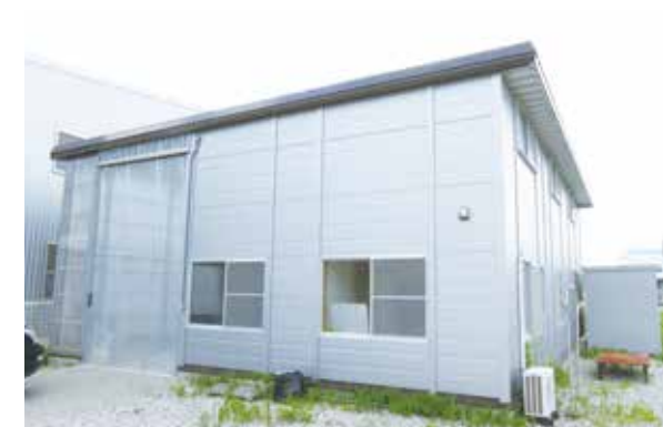
補助事業用に新たに建設した実験棟
