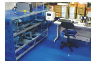
レーザーマーカ（パソコン接続） およびロータリーテーブルの設置
