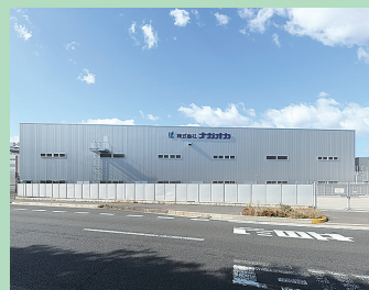
（第二工場外観）
