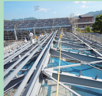
体育館新築屋根工事
