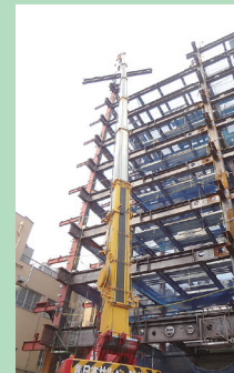
ホテル新築工事
