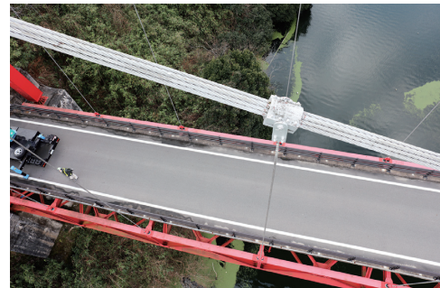
ドローン橋梁撮影
