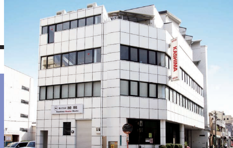
本社ビル外観
