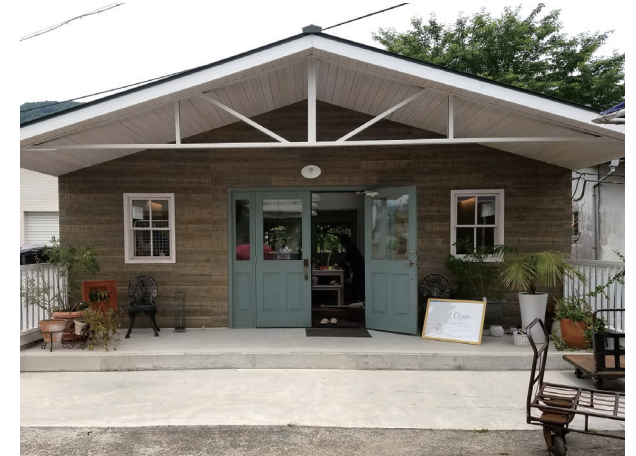
敷地内の展示場
