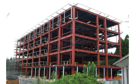
鳥取看護大学の鉄骨建方
