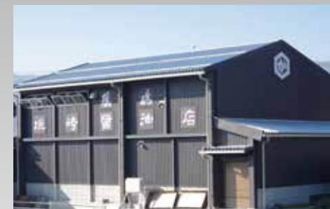
導入に合わせて新築した本社工場
