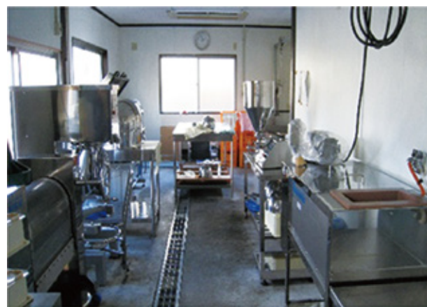
本事業で導入した栗加工設備
