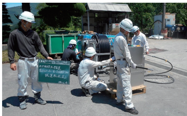
動力挿管機能付加システムの試運転状況 1
