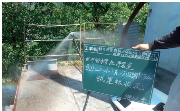
動力挿管機能付加システムの試運転状況 2
