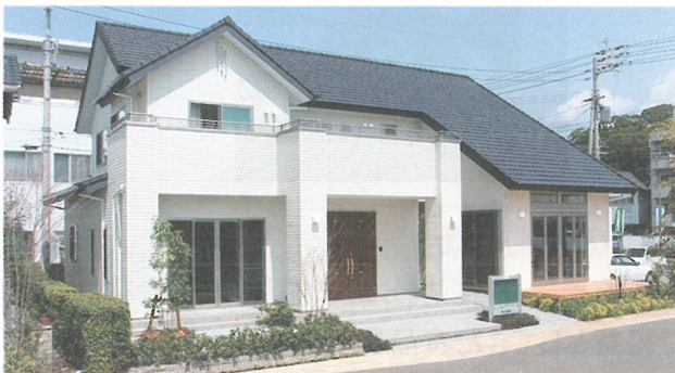
注文住宅（写真はモデルハウス）
