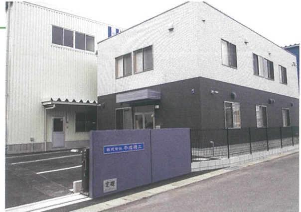
【新築した本社工場外観】
