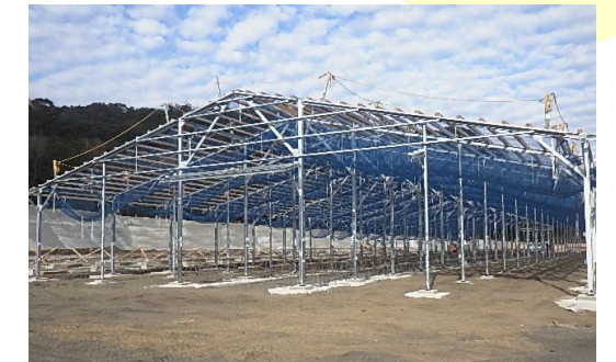
建方中の牛舎
