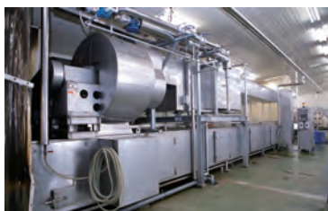
連続加熱水蒸気装置プラントを要した同社森工場
