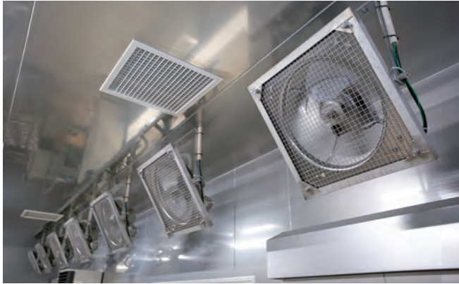
窒素を噴霧し扇風機で窒素を行きわたらせる
