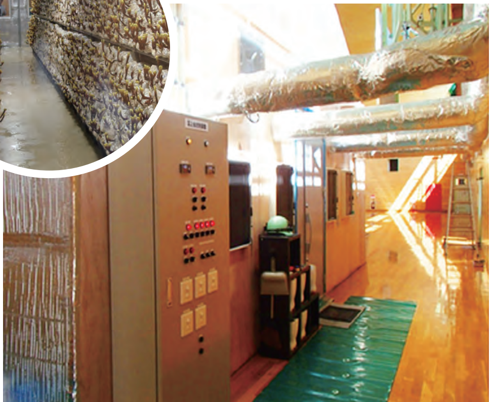
生産ハウスの暖房及び温度維持をする「木質ペレットボイラー」と熱交換器温風システム「プレート式熱交換器」
