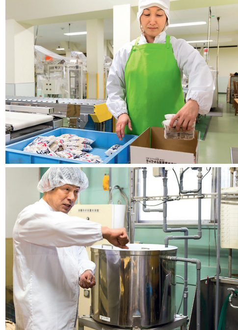
無塩乾麺専用の送水システム
