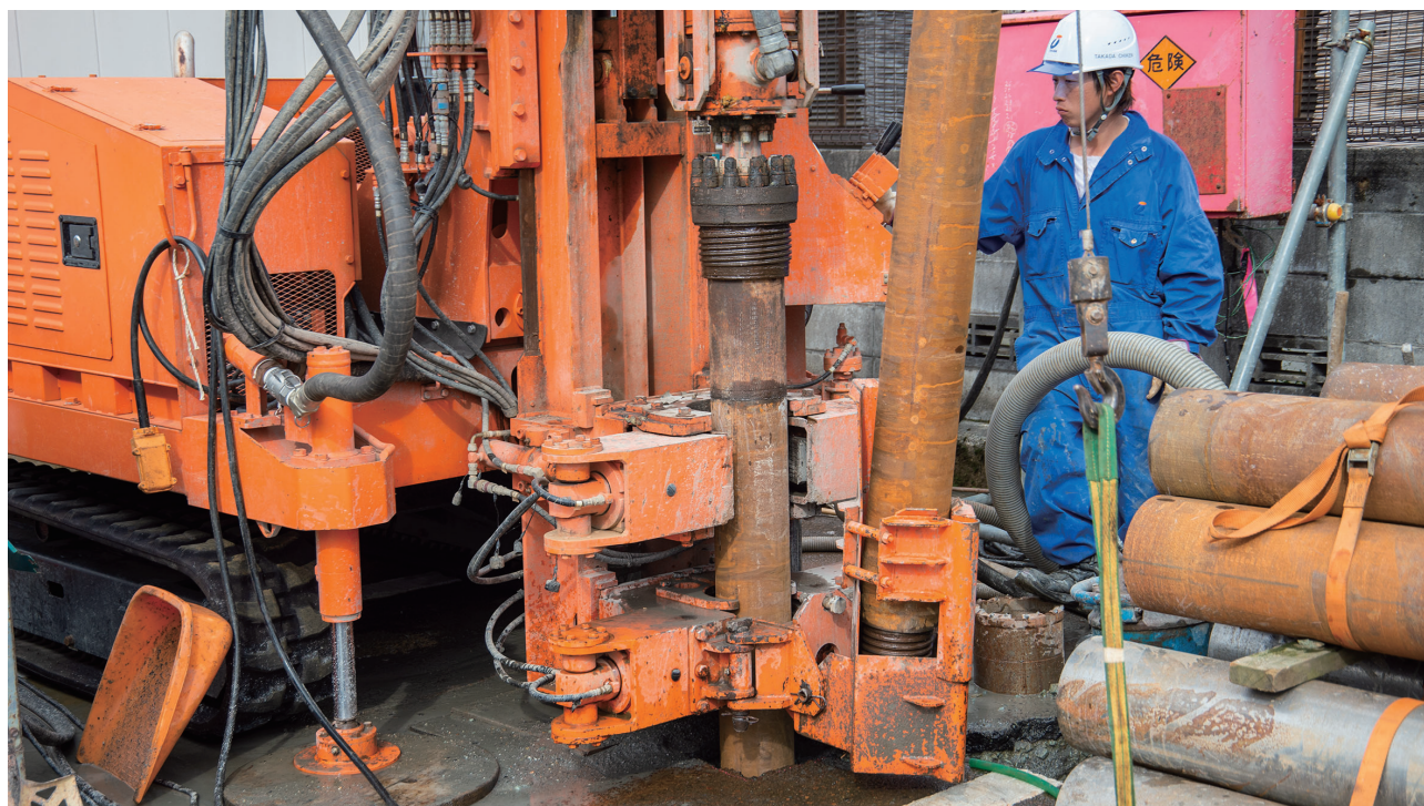
古くなった井戸を代替えて掘削している
