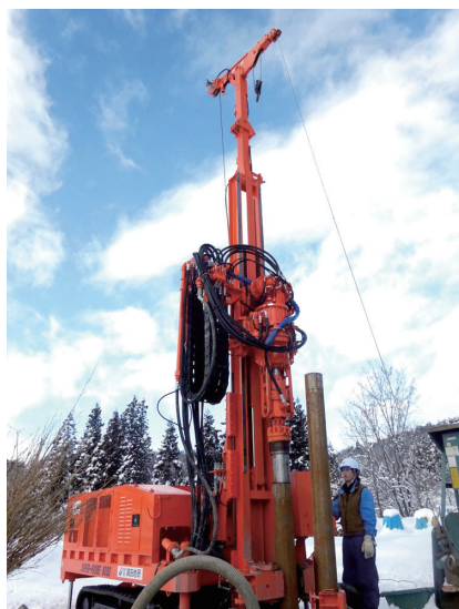
最新鋭掘削装置を導入
