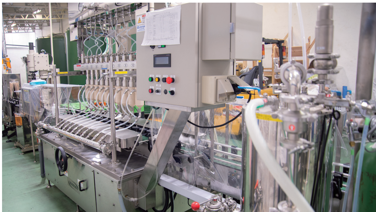
炭酸ガス注入充填と通常充填が使い分けられる微炭酸ガス充填機を導入
