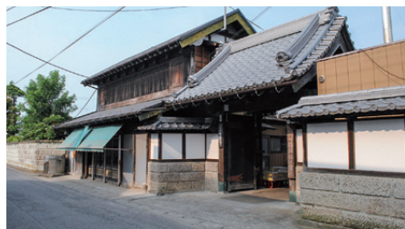
被災前の店舗兼住宅
