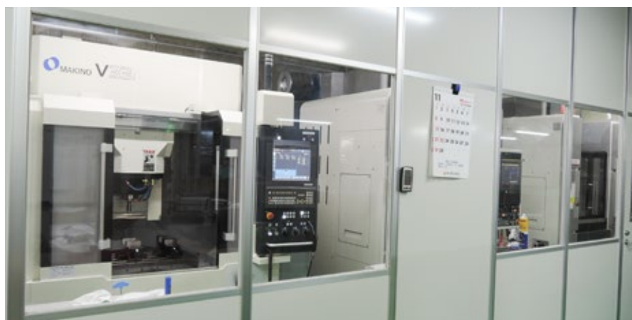
空調設備を整えたマシニングセンタ専用スペース
