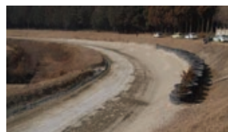
写真1.「丸和オートランド那須」ダートコースの一部
