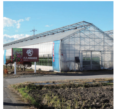
エフ・エフ・ヒライデ本社に隣接する温室
