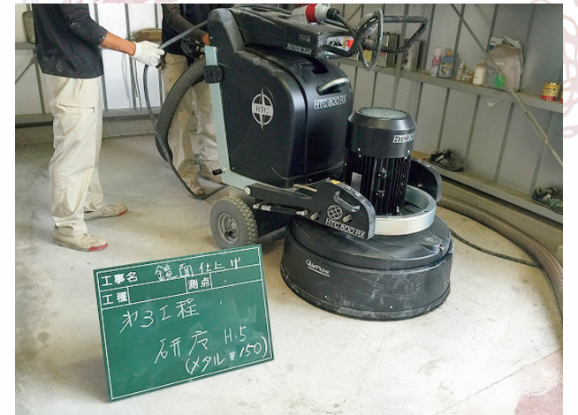
研磨ブレードによる研磨
