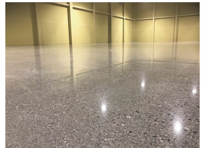
工程後の床の様子
