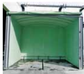
新規養生施設2室+改修
