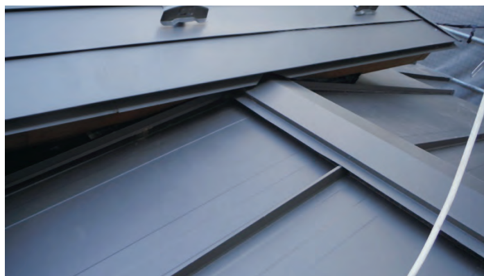
導入した折曲機で加工した屋根材
