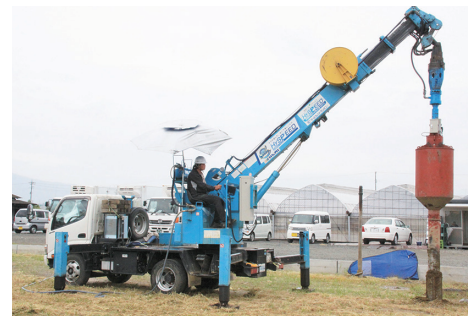
◀ ハイスピード(350)工法による地盤改良工事
