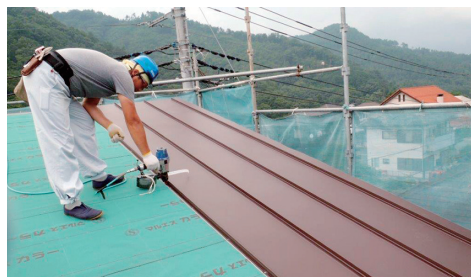
◀ 自社加工した屋根板金を施工中
