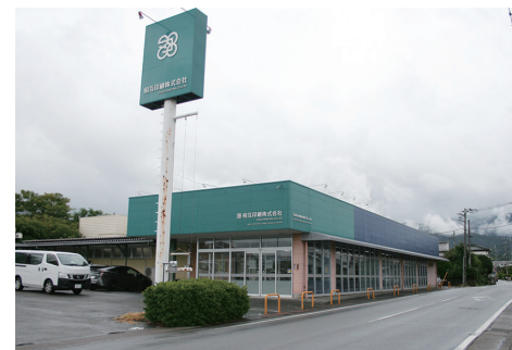
外観・元スーパーマーケットだった建物
