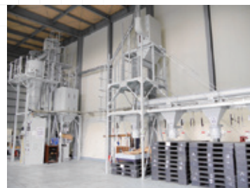
自家精米設備
