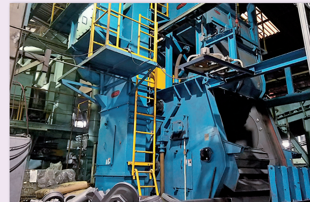
鑄物仕上げ自動化ライン装置
