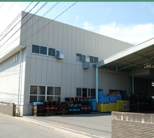
■ メッキシステムを導入した踏分工場
