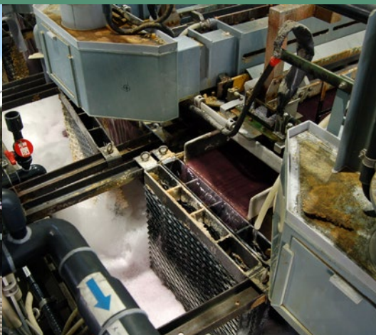
■ メッキ浴は濾過、循環させて性能を維持する
