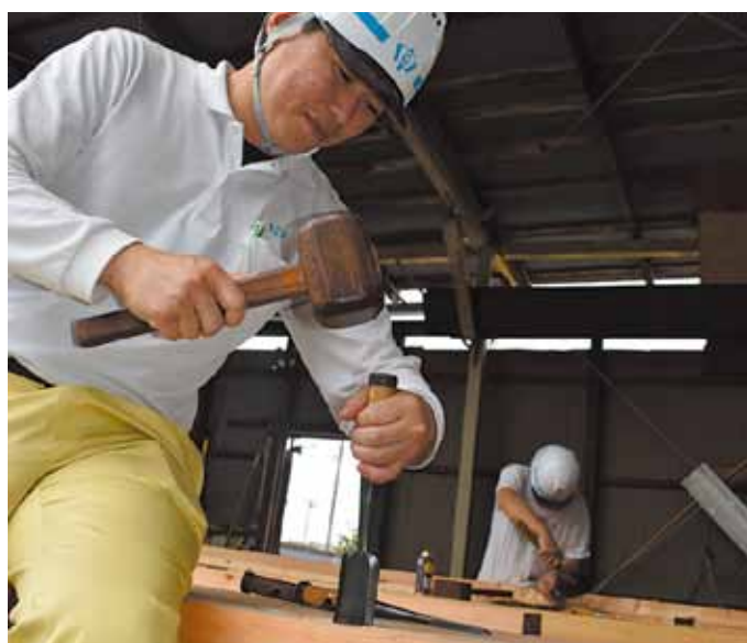
鑿（のみ）で仕口を仕上げる
