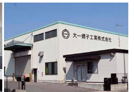
フォーマーを導入した第二工場
