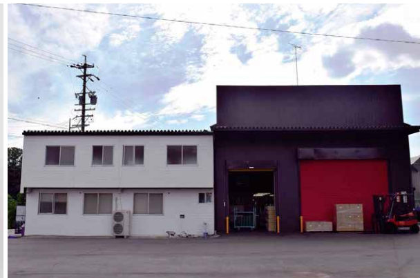
平成29年に稼働した膝折工場
