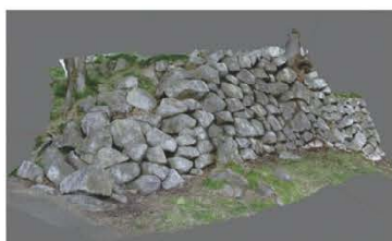
3次元レーザースキャナーとドローンによる点群データをハイブリッド解析して作った抜けのないポリゴンデータ
