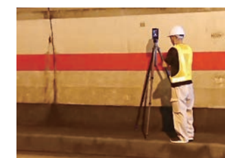
三次元スキャナーによるトンネル断面調査
