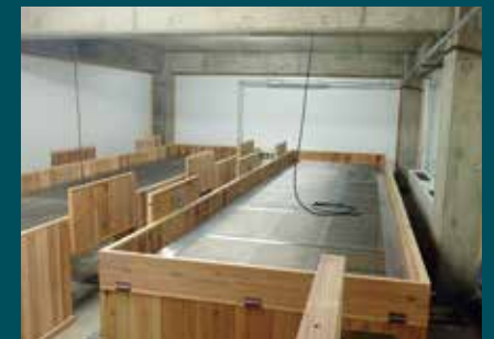
【更新した製麴室】
