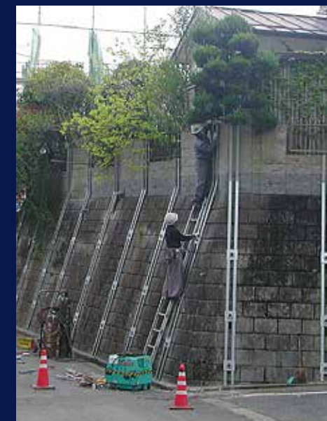
【排水補強パイプ】
