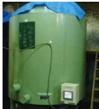
【新設のクーリングタンク】
