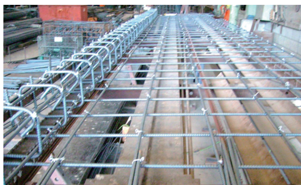
鉄筋加工組立例
