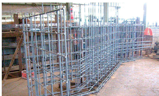
鉄筋加工組立例
