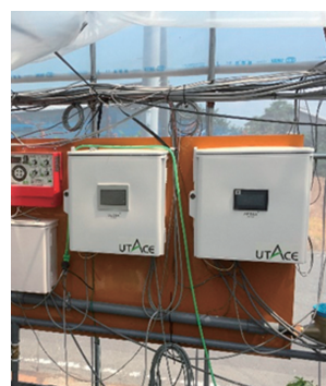
導入設備：ハウス内換気装置と制御装置
