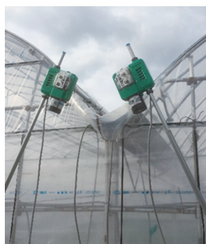
導入設備：ハウス内換気装置と制御装置
