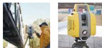
3次元計測器を用いた作業手法
